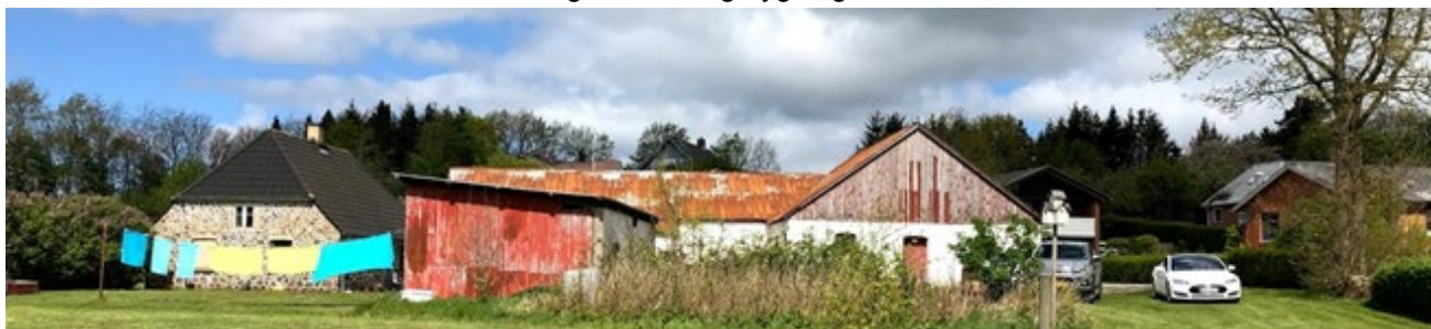
Eksisterende bebyggelse set fra syd.
